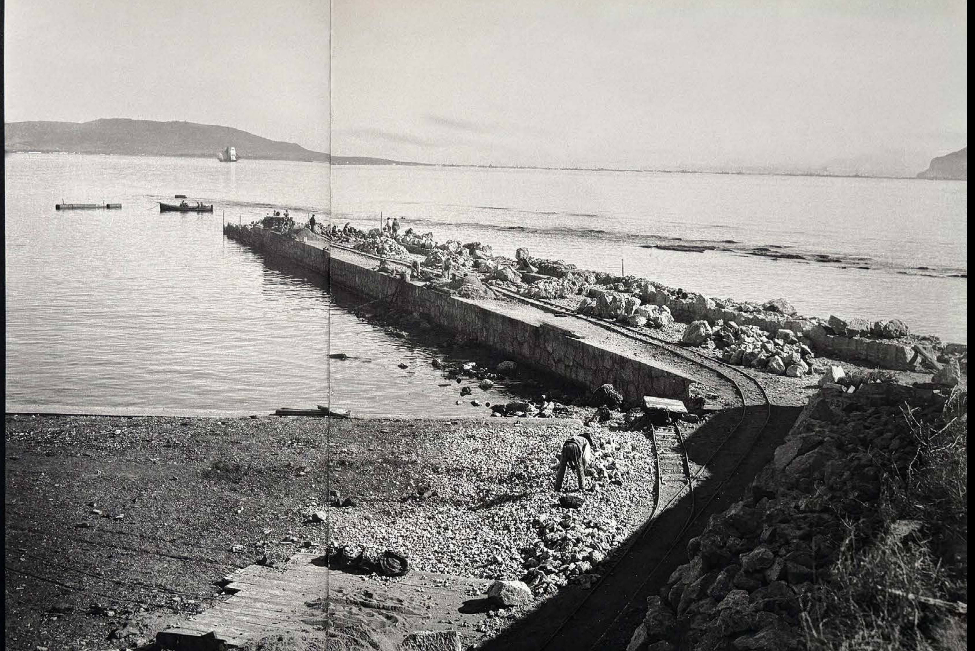
Estado de las obras del dique de Isla Verde en 1919. (Archivo APBA) The state of works on the Isla Verde breakwater in 1919. (APBA Archives)
