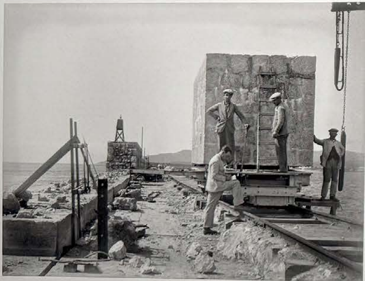
Organización del taller de bloques. La grúa Goliat se encargaba de cargarlos en las vagonetas que los trasladaban hasta la Titán. El sistema es semejante al que hoy utilizan los modernos trastainers de contenedores. Hacia 1924. (Archivo APBA)
