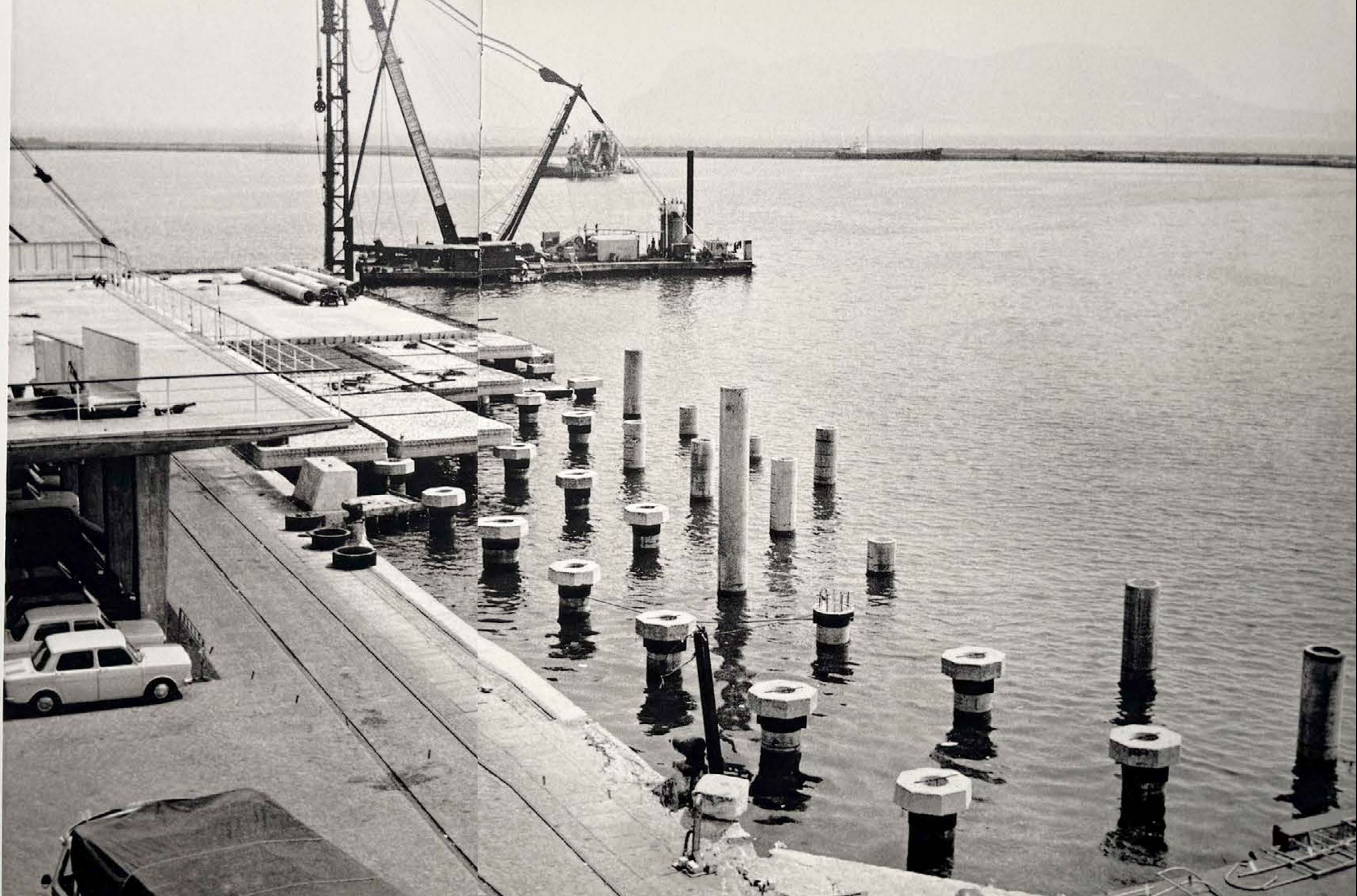
Ampliación de los atraques para ferries en 1970. Para su construcción se utilizaron pilotes y tableros de hormigón. (Archivo APBA) Extension to the ferry docking berths in 1970. Work was carried out using concrete pillars and slabs. (APBA Archives)
