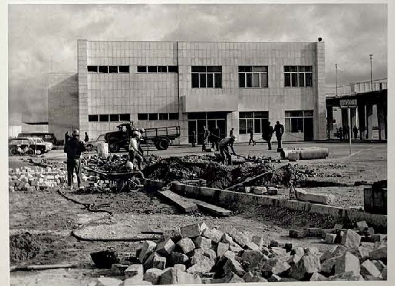
Estado de las obras de la estación marítima en los años 1967 y 1968. En la foto superior, al fondo, puede verse el antiguo edificio, que finalmente sería demolido. (Archivo APBA)
