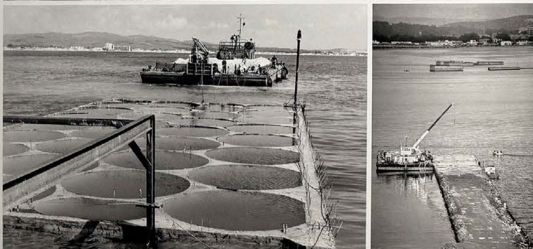
El dique ha sido ampliado en tres ocasiones para dar abrigo a los nuevos muelles. Para llevar a cabo estas ampliaciones, se han utilizado grandes cajones de hormigón fabricados en diques flotantes llamados Cajoneros. Años 1978, 1986, 1991. (Archivo APBA)
