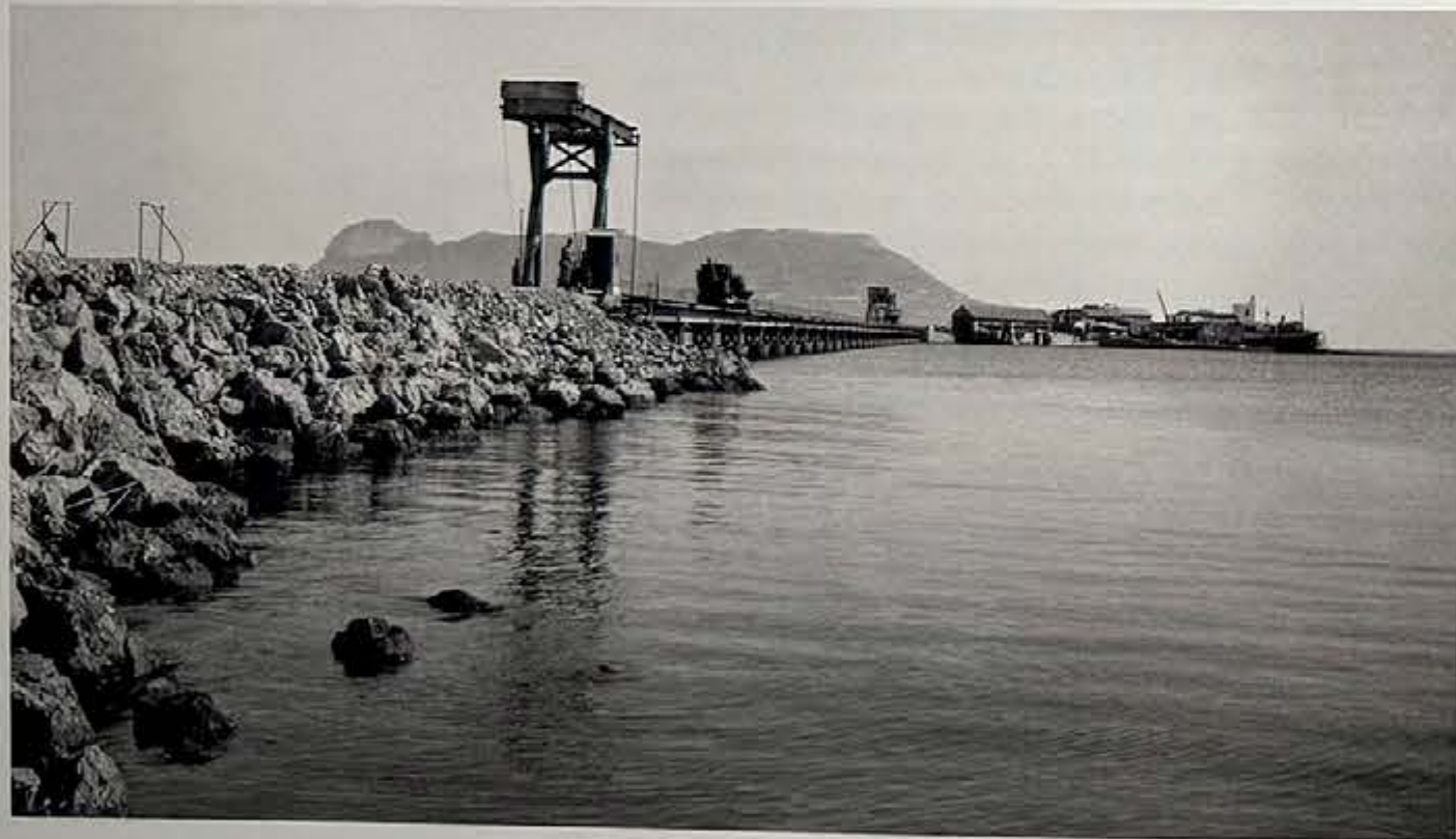
⇨ Puente sobre pilotes para el paso del ferrocarril de vía estrecha. En primer término, mecanismo de elevación del tramo inicial para facilitar el paso de embarcaciones. Año 1931. (Archivo APBA)
