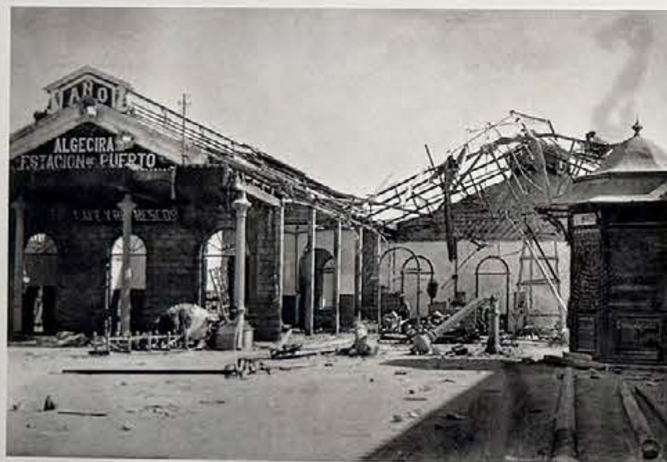
Demolición de la primera estación del Puerto en el año 1947. (Archivo APBA)
